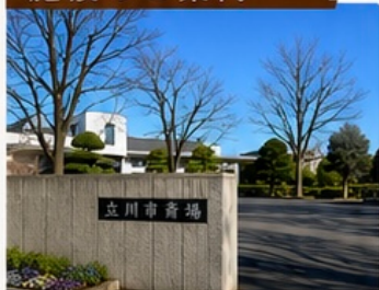
外観（立川市斎場）
